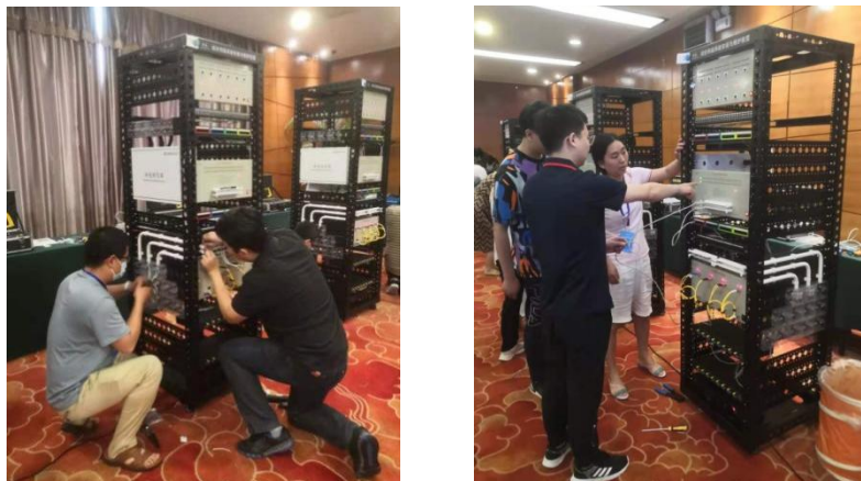
图 10 “综合布线系统永久链路搭建与测试”技能实训
